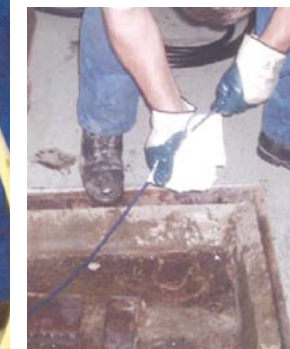
Inspektion durch Revisionsöffnungen
