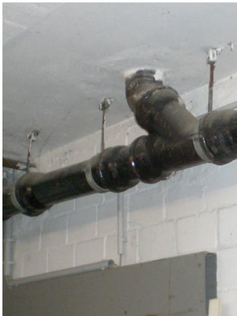
Abhängen der Leitungen unter der Kellerdecke
