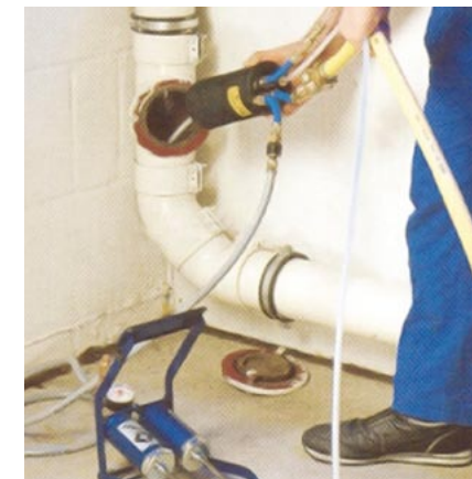
Inspektion durch Revisionsöffnungen
